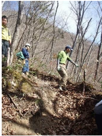
作業前（深い浸食がみられる）
